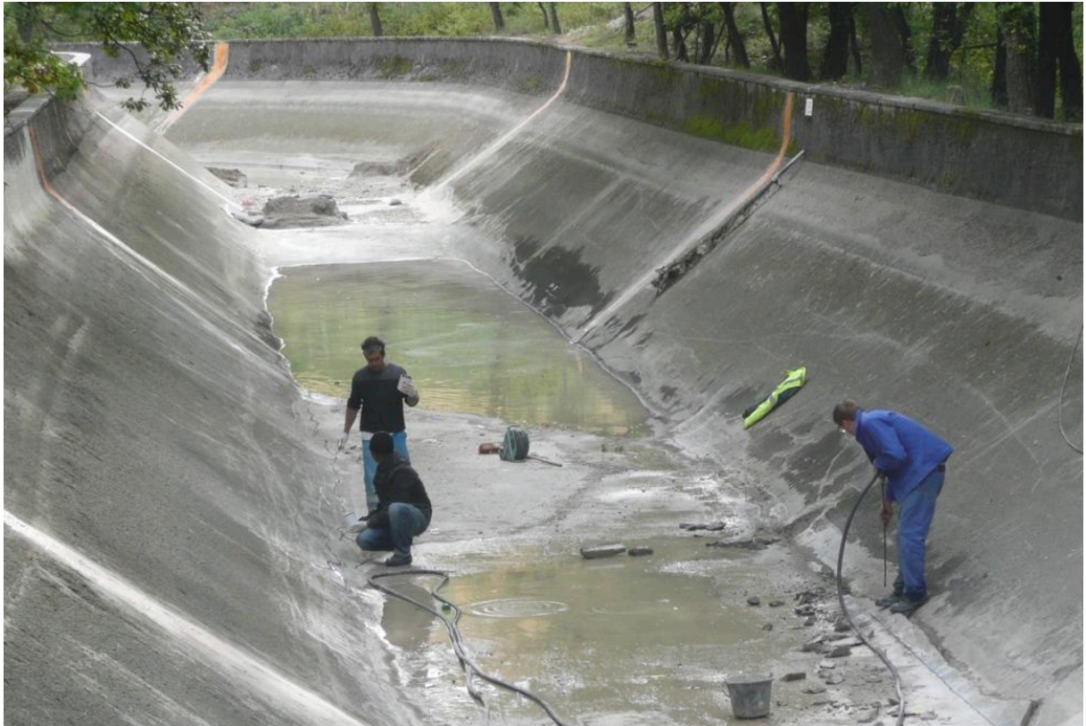
Le nettoyage du canal nécessite régulièrement des mises à sec.
